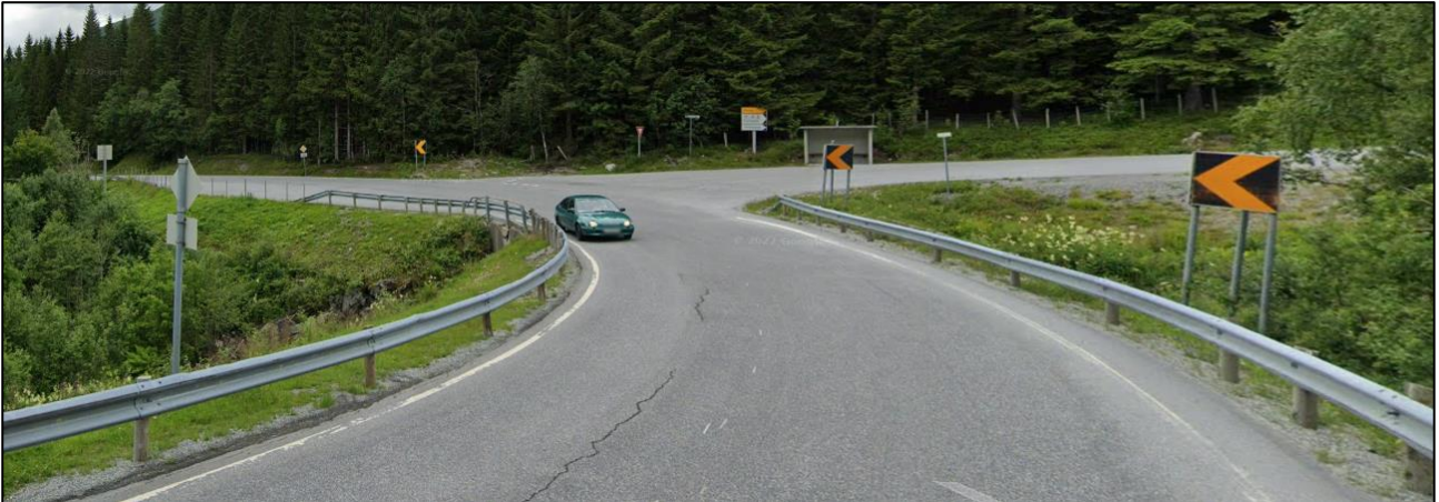
Figur 6 Sikt mot krysset, retningsmarkering for krapp kurve. Nysætervegen mot høgne (Google Street View aug. 2022)
